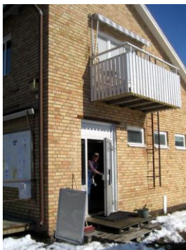
Hörnet på Centrumhuset
